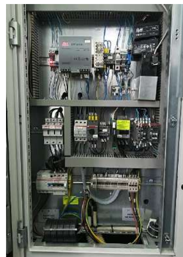
Fig. 2.7: Convertitore statico con elementi di dettaglio
