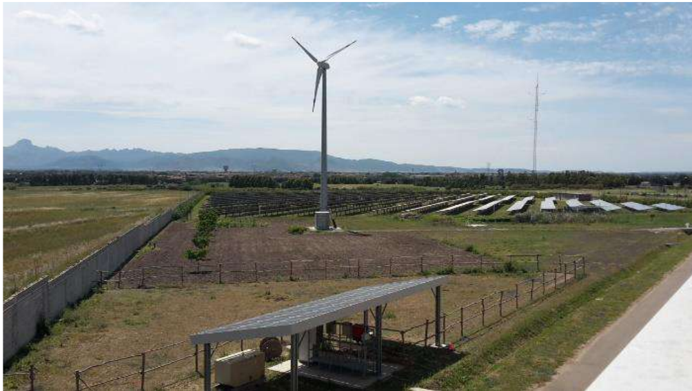
Fig. 1: Impianto pilota di Terralba (OR) - progetto SMEEA
