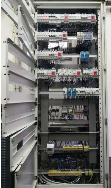
Fig. 2.5: Quadro elettrico generale con dettaglio PLC
